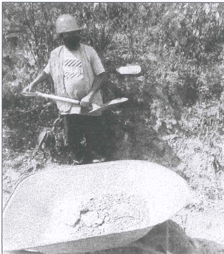
Foto N° 04: Remoción de derrumbes.
