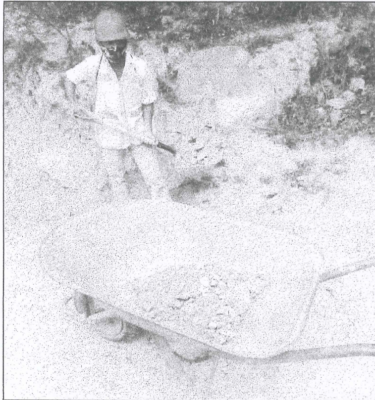
Foto N° 03: Limpieza de cunetas.
